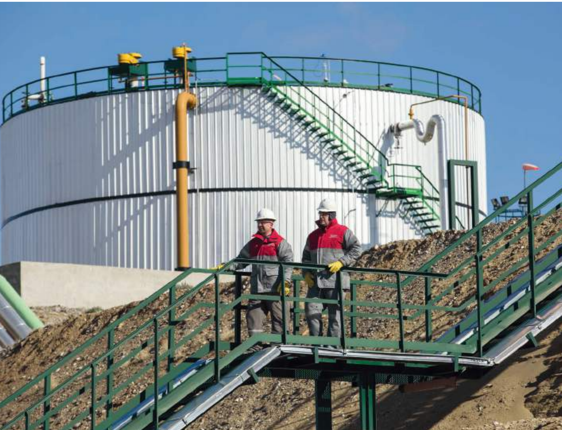
Las plantas de inyección de agua salada (PIAS) separan el petróleo del agua de formación, que luego es tratada para ser reinyectada en los reservorios bajo recuperación secundaria.
