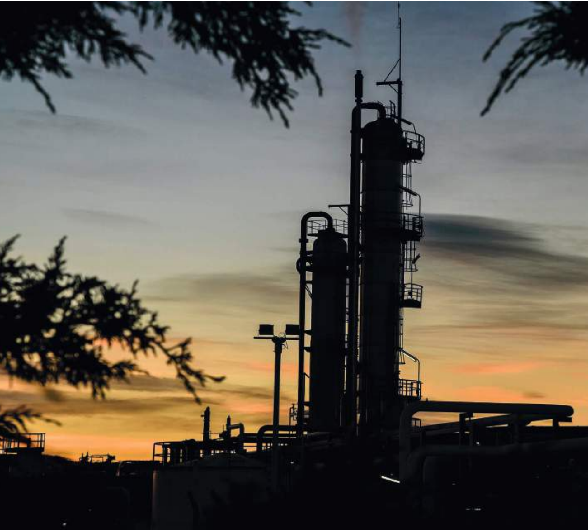
Amanecer en la Planta de Tratamiento de Gas Zorro, inaugurada en el año 2000.
