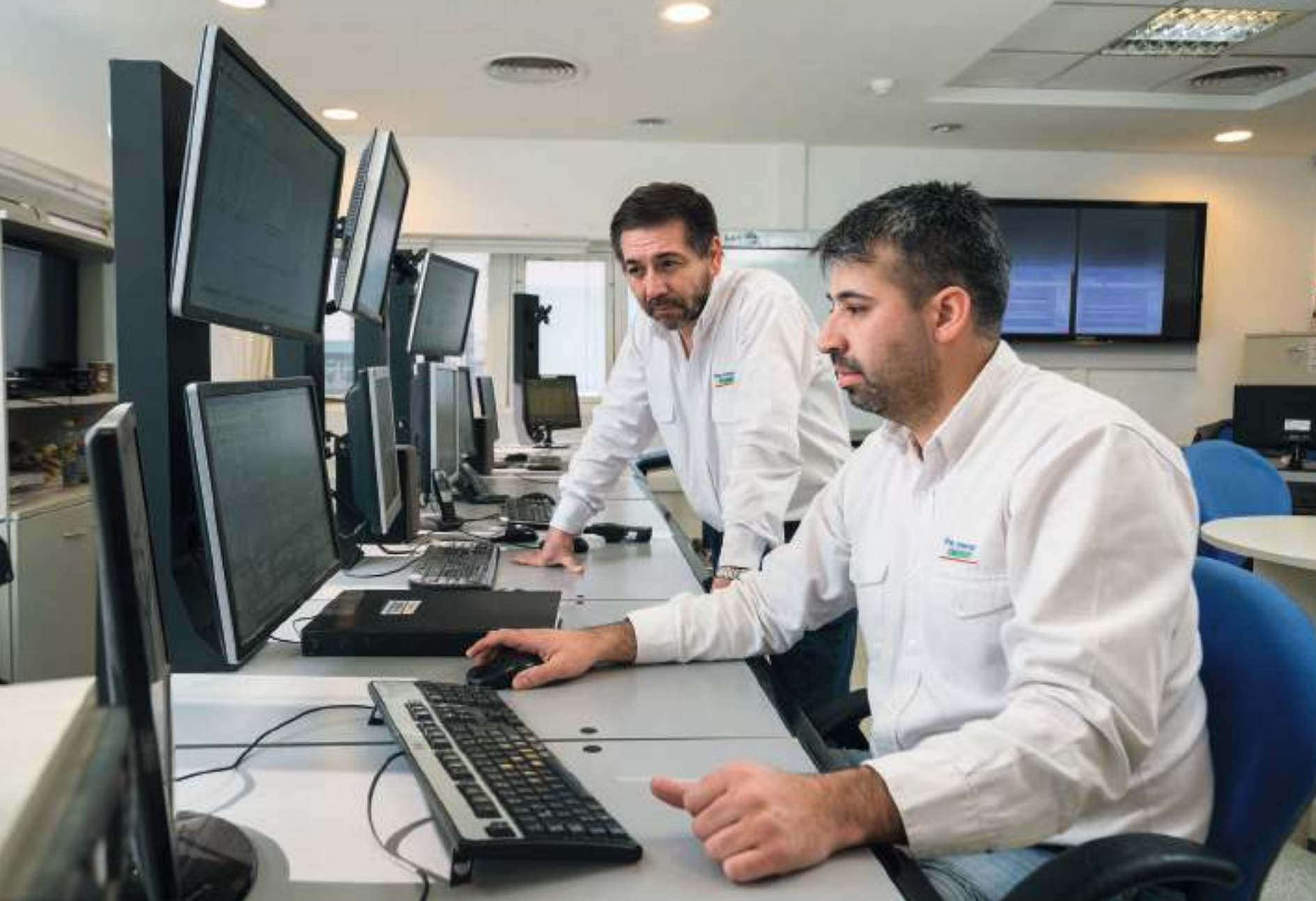
Sala de Control de la Planta de Generación de Energía en Cerro Dragón.
